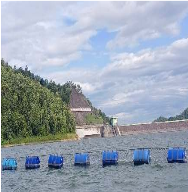
Gbr 4. Bendungan Batutegi yang dilihat menggunakan perahu kapal
