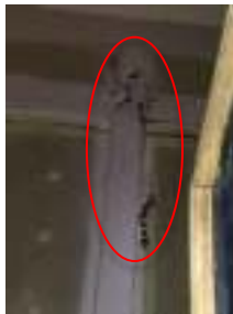
Gambar 5 Kerusakan pada rangka dinding
